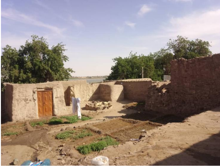
لوحة رقم (5): نموذج من البيوت التاريخية التي تهدمت أجزاء منها بفعل الأمطار الأخيرة واستخدام أجزاء منها للزراعة
