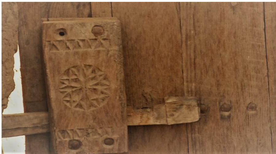
لوحة رقم (3) شكل يوضح الكالون والمفتاح الخشبي للبوابة في منطقة المحس
