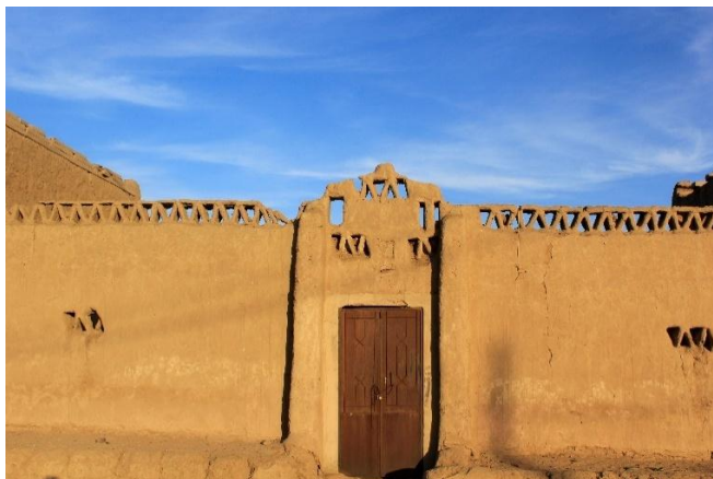
لوحة رقم (7): شكل تصميم المثلثات أعلى الجدران
