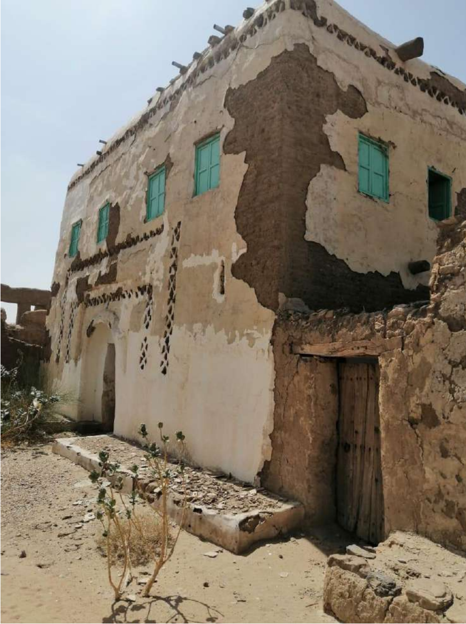
لوحة رقم (6) تأثير تغير المناخ على سلامة المباني الطينية في بلدة الخندق التاريخية والذي يظهر في تآكل أسس المباني وجدرانها
